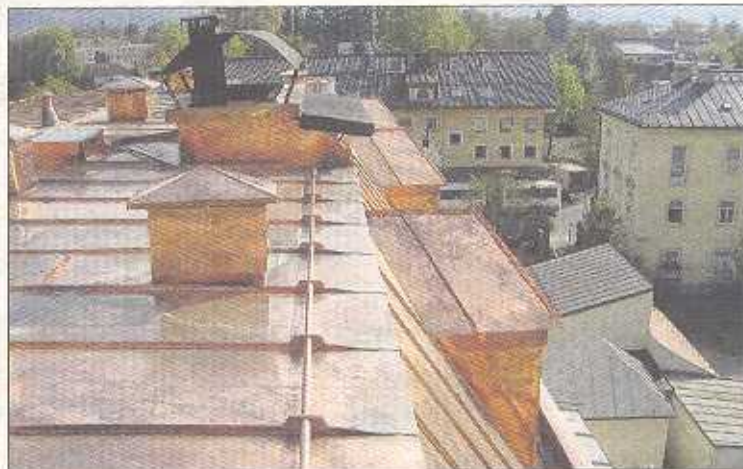
Das Gebäude aus den 1960er Jahren verfügt über ein Mansardendach mit zahlreichen Dachentlüftungen und Gauben. Die vielen Dachdurchbrüche und die geringe Dachneigung stellten die Firma vor große Herausforderungen.
