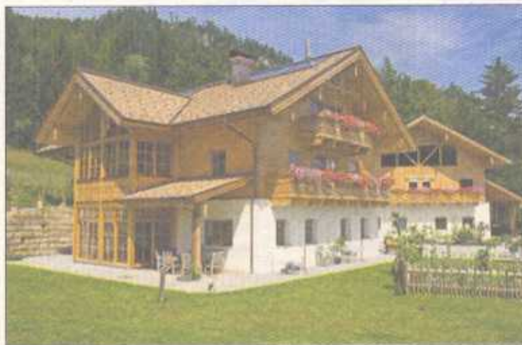
Durch den Einsatz von Lärchenholz an exponierten Bauteilen war es möglich, auf sämtliche chemische Holzschutzmittel zu verzichten. Foto: PHB
