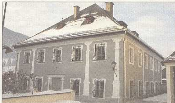
Bei dem Sanierungsprojekt wurde die komplette Außenfassade mit aufwändiger Kalktechnik wiederhergestellt.
