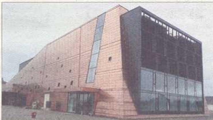
Die Dachbau GmbH erhielt für die Fassadengestaltung des Konzerthauses Grafenegg von der Jury einen Anerkennungspreis. Foto: Dachbau GmbH
